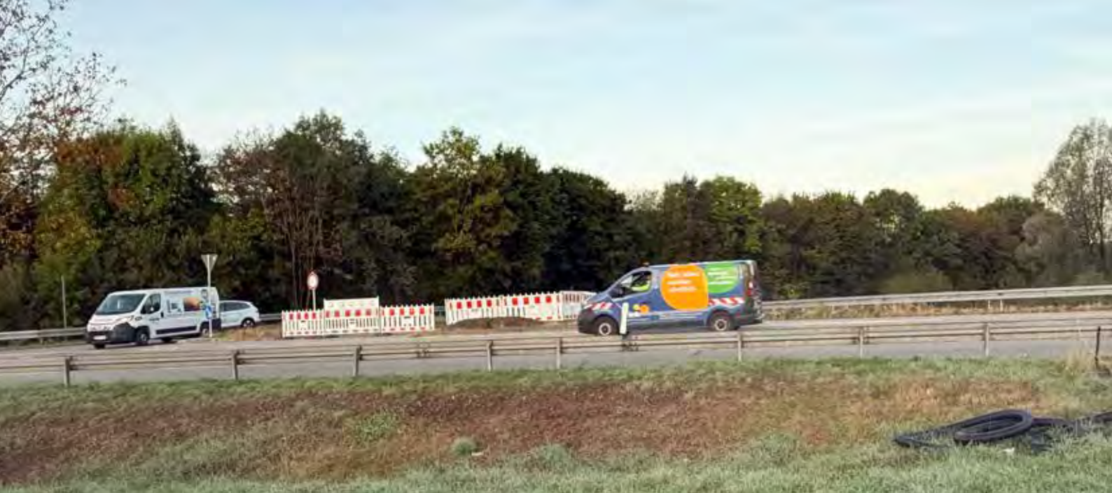
Die Bauarbeiten für die Ampel haben begonnen.
