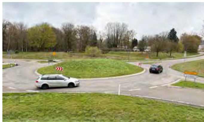
Der Kreisverkehr an der Abfahrt zu Stegen ist ein Beispiel für einen kleineren, günstigeren Kreisverkehr. Foto: Heike Schwende
